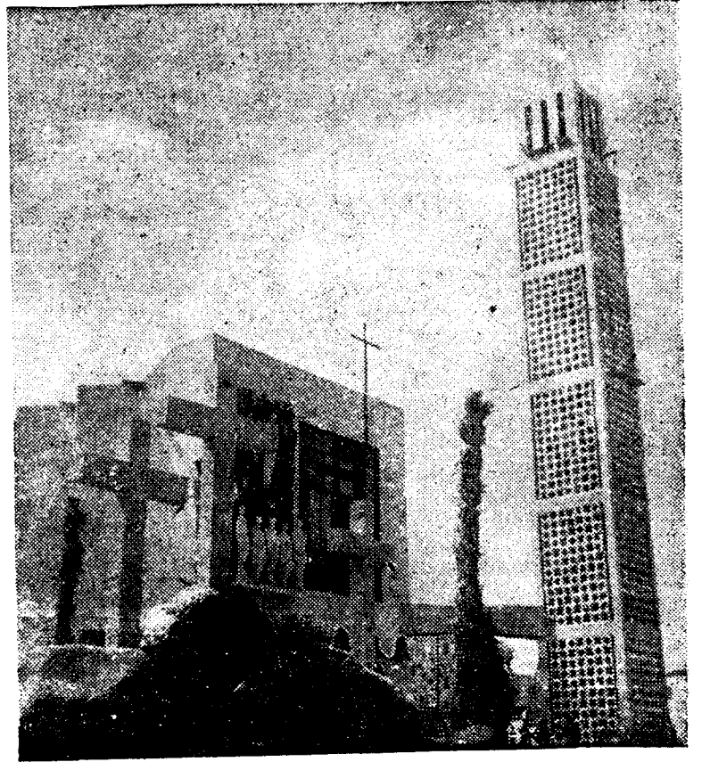
Fotografía de la Iglesia de Schamann obtenida por el objetivo de Urquijo, en la que se puede observar la originalidad de la misma, con la separación de la iglesia propiamente dicha, del baptisterio y de la eterea torre por medio de un puente
